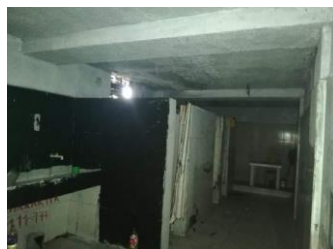
Estado actual de baños
