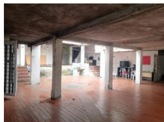
Estado actual de baños
