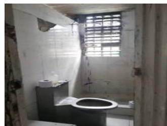
Estado actual de baños
