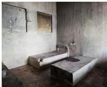
Estado actual de camastros
