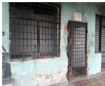
Fachada de alojamiento, patio de responsabilidad
